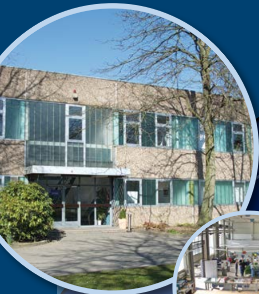
Trainingszentrum Aachen, TÜV NORD Bildung
